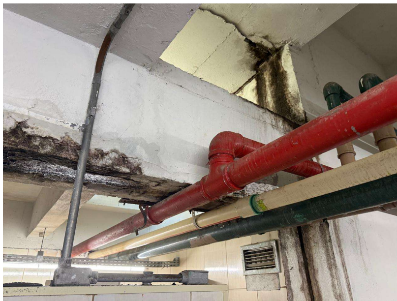
Foto 2: Viga – Área de Manutenção
