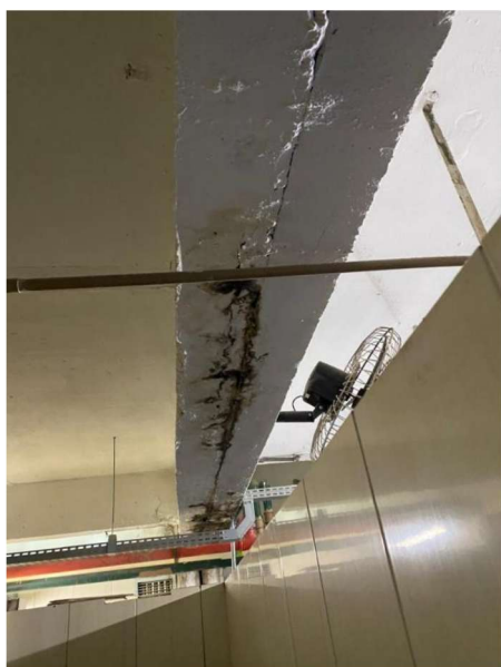
Foto 3: Viga – Área de Manutenção
